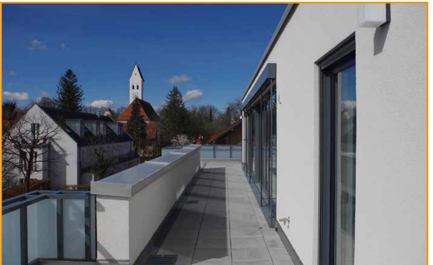
Blick auf die teilumlaufende Dachterrasse der Wohnung Nr. 17
