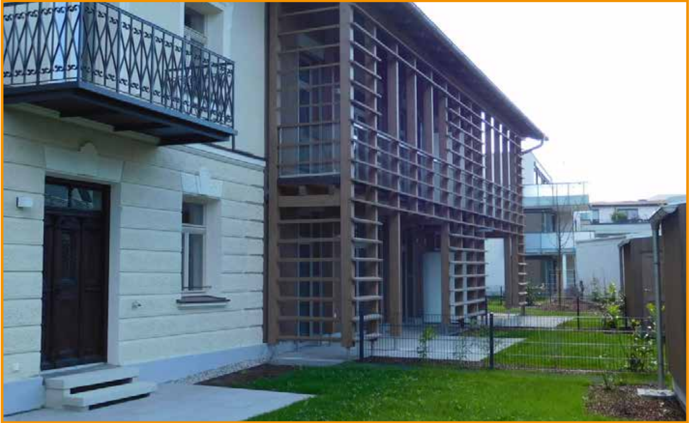
Seitlicher Anblick des unter Denkmalschutz stehenden ersten Gebäudeteils mit dem angegliederten zweiten Mehrfamilienhaus
